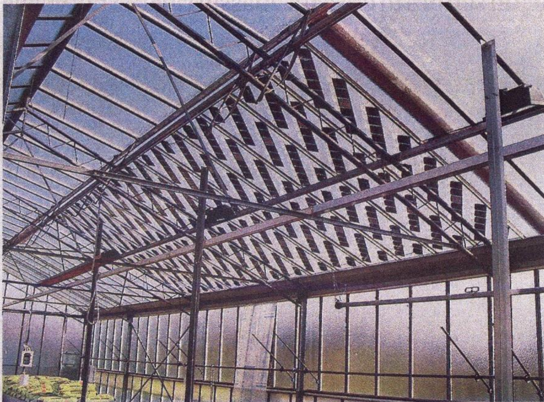
La serra con i pannelli solari sperimentali e, a lato, Giacomo Roccaforte
